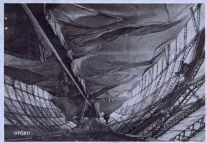
Bild Nr. 83: Füllung der Traggaszellen nahezu beendet
