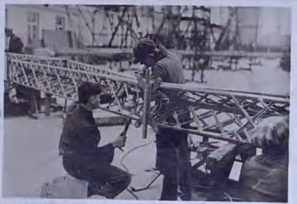
Bild Nr. 70: Ein Ring-Eck wird genietet
