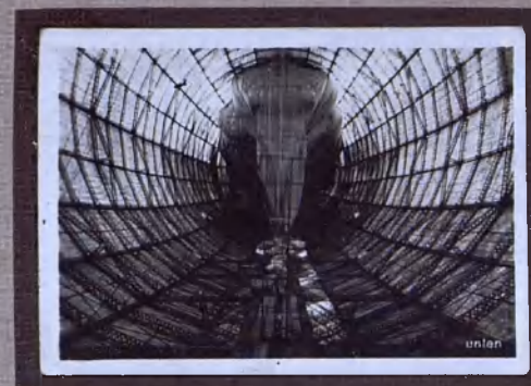
Bild Nr. 68: LZ 126 Einbringen der Gaszellen
