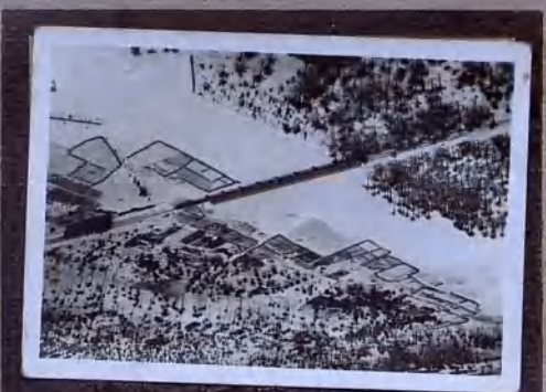
Bild Nr.230: Bahnbrücke bei El Arisch
