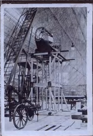
Bild Nr. 76: Anbau einer Seitengondel
