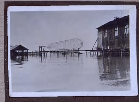
Bild Nr. 16: LZ 6 im Bau 1909
