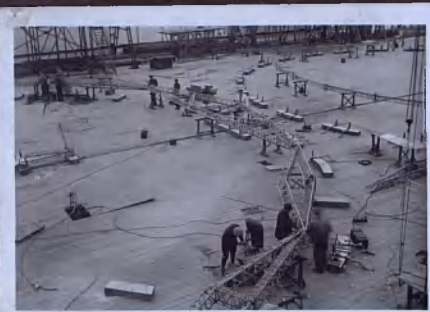
Bild Nr. 71: Ein Hauptring wird zusammen- gesetzt
