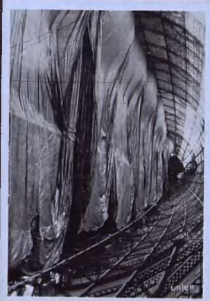
Bild Nr. 82: Mit dem Füllen der Traggaszellen wird begonnen
