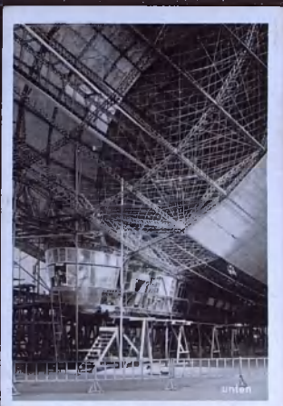
Bild Nr. 78: Führergondel im Bau
