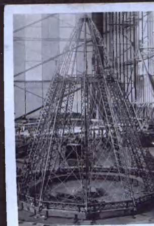
Bild Nr. 75: Heckspitze im Bau
