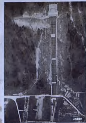
Bild Nr. 241: Walchensee-Kraftwerk
