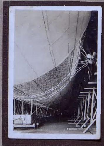
Bild Nr. 1: LZ 1 im Bau 1899
