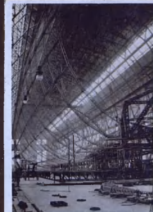
Bild Nr. 73: Gerippe im Bau
