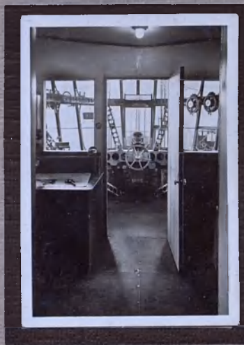
Bild Nr. 87: Blick in den Führerraum
