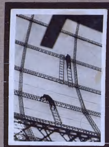
Bild Nr. 79: Arbeiten an einem Gerippfeld
