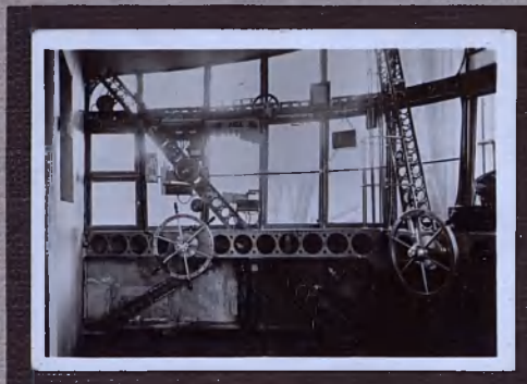
Bild Nr. 88: Führerraum mit Höhen- und Seitensteuerstand
