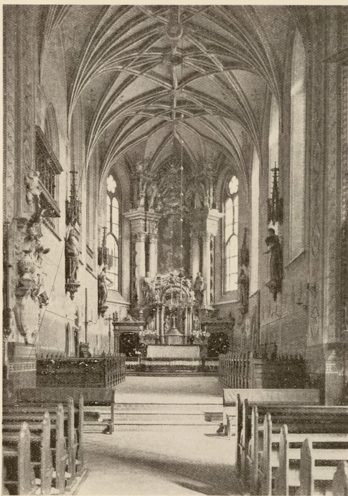
Kath. Pfarrkirche, Blick nach dem Hochaltar.
