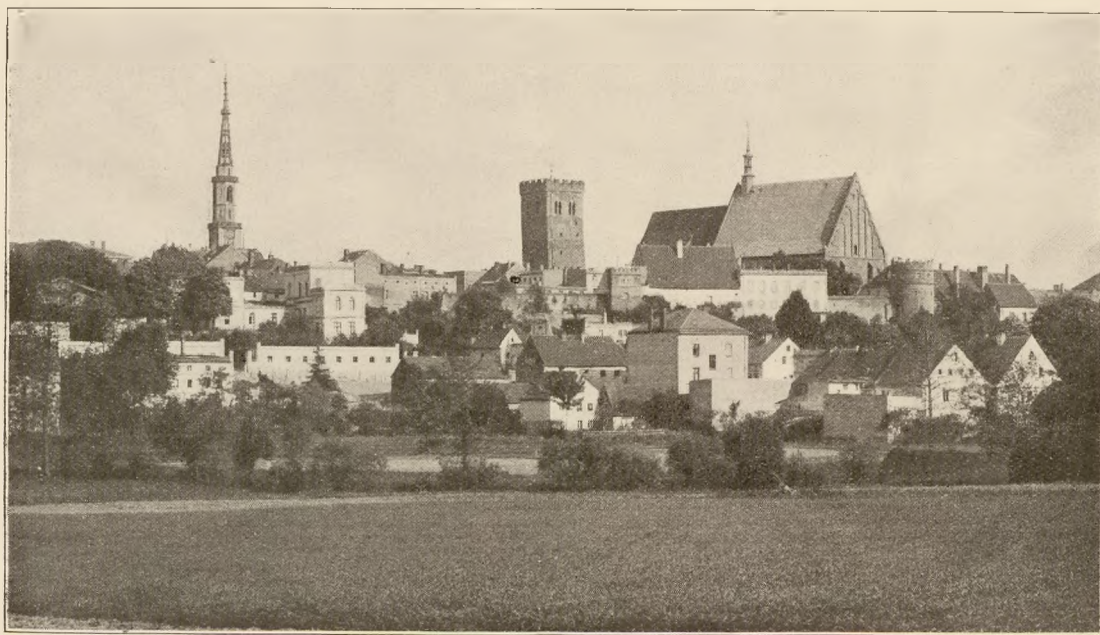
Blick nach der Stadt von der Passottinerstraße aus.
