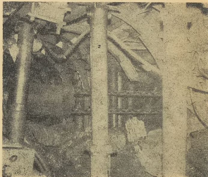
Rys. 3. Skrzyżowanie chodnika ze ścianą
