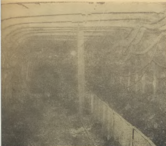
Rys. 5. Ogólny widok chodnika podścianowego
