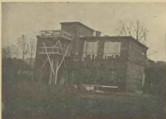
Z robotami budowlanymi w tym roku skończone. Blacharz zaczyna dach pokryć z blachą pocynkowaną.
