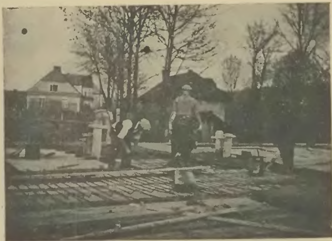
Uzbrojenie i betonowanie stropów żelbetonowych nad piwnicą
