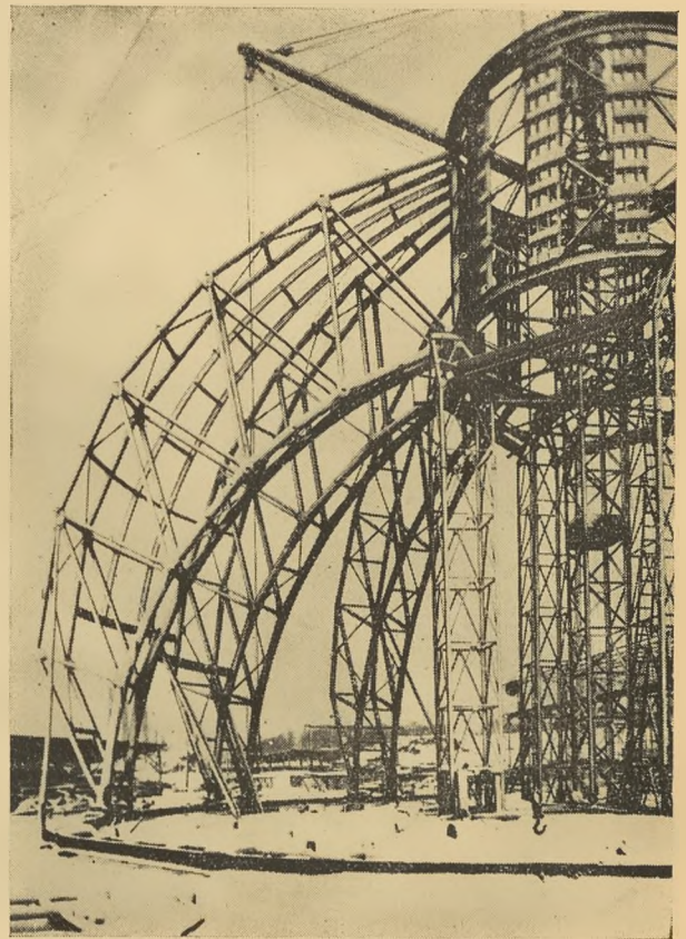
Fragment konstrukcji stalowej, czekającej obecnie w Chorzowie na transport do Warszawy.
