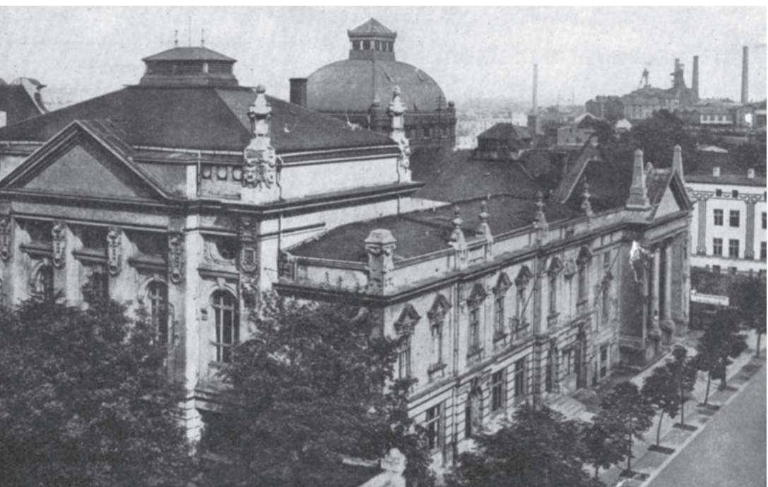
Direkt nebeneinander und im gleichen Jahr 1901 erbaut: Das Konzerthaus (vorn) und das Stadttheater (dahinter) an der Gymnasialstraße in Beuthen. Im Hintergrund sind (links) der Turm der evangelischen Kirche und (rechts) das Steinkohlenbergwerk Heinitzgrube zu sehen.
