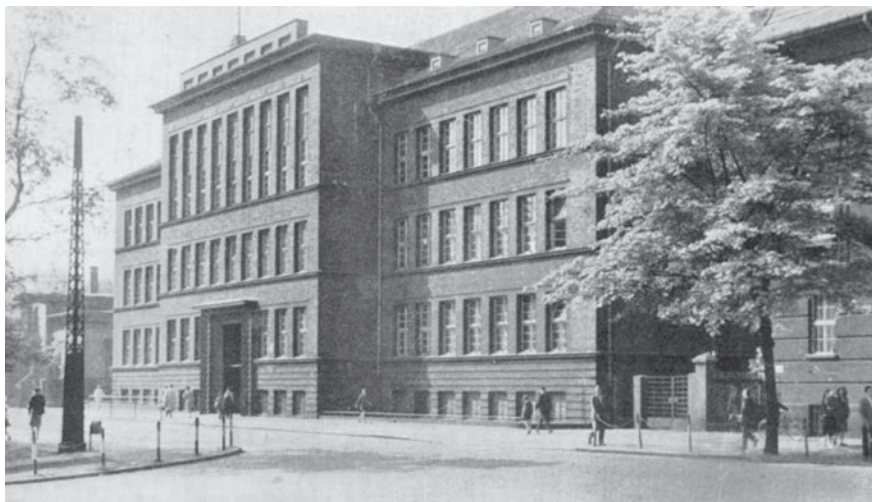
Das Realgymnasium, von der Bismarckstraße aus gesehen. Links daneben, wo man ein altes Wohnhaus mit Flachdach erkennen kann, sah die Stadtplanung einen Neubau für das Hindenburg-Gymnasium vor. Er kam aber nicht mehr zur Ausführung.
