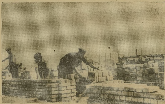
Budujemy i ciągle budujemy. Rosną „pod niebo” mury nowych bloków, w których zamieszkają nowi mieszkańcy. Budowlą którą widzimy na zdjęciu powstaje w Rakowie i już niedługo będzie gotowa. Jeszcze tylko jedna kondygnacja, wykończenie wnętrza, wstawienie drzwi i okien.
