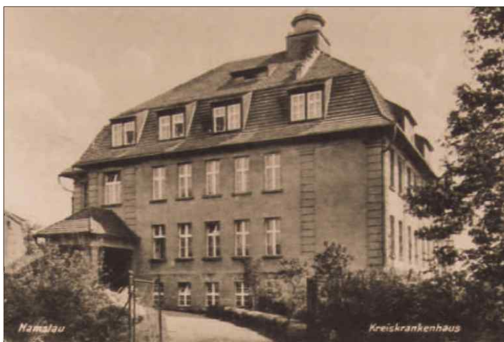
Fot. 3 Szpital Powiatowy mieścił się w budynku przy ul. Piłsudskiego 15 w latach 1919-1956. Następnie funkcjonowała tu Przychodnia Zdrowia, przeniesiona na przełomie XX i XXI w. na ul. Mickiewicza. Obecnie budynek jest nieużytkowany i stopniowo niszczeje
