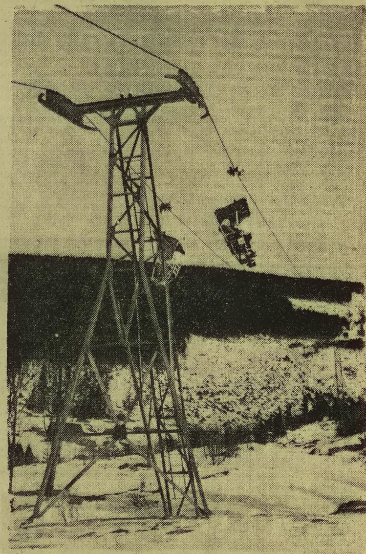
Wyciąg krzesełkowy z odpinanymi dwuosobowymi wagonikami na Śnieżkę w Karkonoszach od strony czechosłowackiej. Takie wyciągi będziemy budowali w Polsce.
