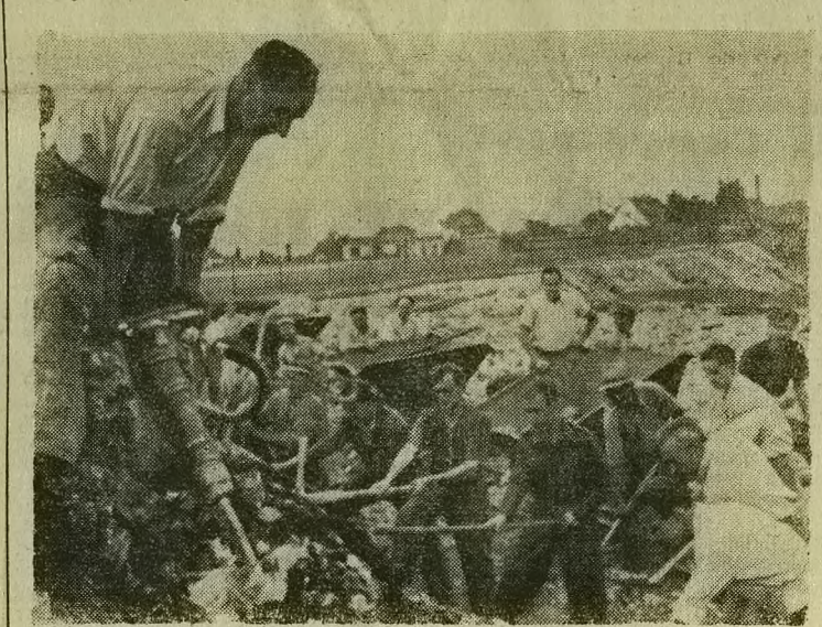
Sportowcy Włocławka w Krakowie przy pracy nad odbudową boiska. Fot. Węglowski
