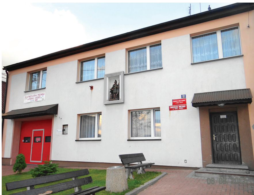
Fot. 4. Figura św. Floriana w niszy fasady budynku remizy OSP i świetlicy wiejskiej w Nowej Wiosce Fot. K. Lach.
