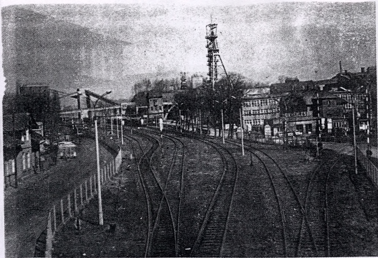
Kop. „Silesia – Po przebudowie szybu nr 3 1971 rok
