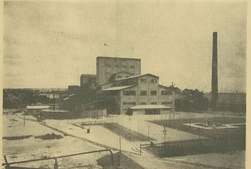
Die neue Aufbereitungsanlage der Neuhofgrube
