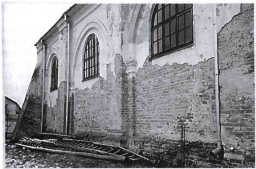
9. Kolejny remont ścian kościoła w Zaturcach. Fot. ze zbiorów autora
