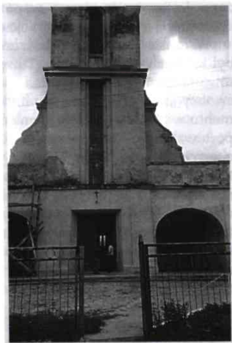
35. Fasada kościoła w Rożyszcach. Fot. ze zbiorów autora
