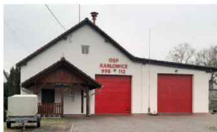
Strażnica została ocieplona, a nowa elewacja pomalowana. Fot. UG Popielów
