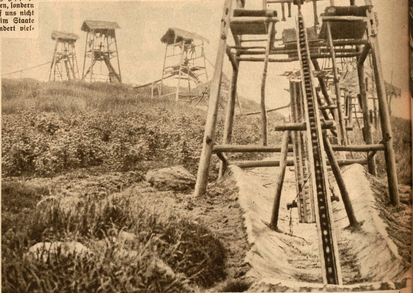
In kurzen Abständen reiht sich ein Tretgestell ans andere, auf dem die Kulis, durch ein Strohdach vor Sonne und Regen geschützt, die Sole über das Bergland pumpen.
