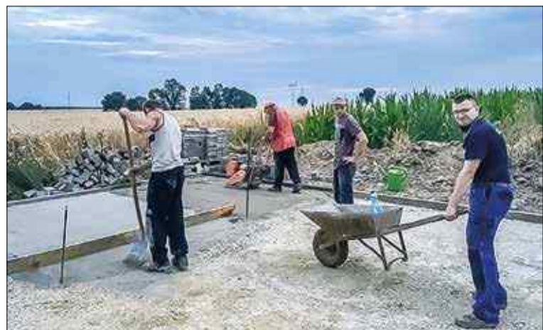
W trakcie budowy parkingu
