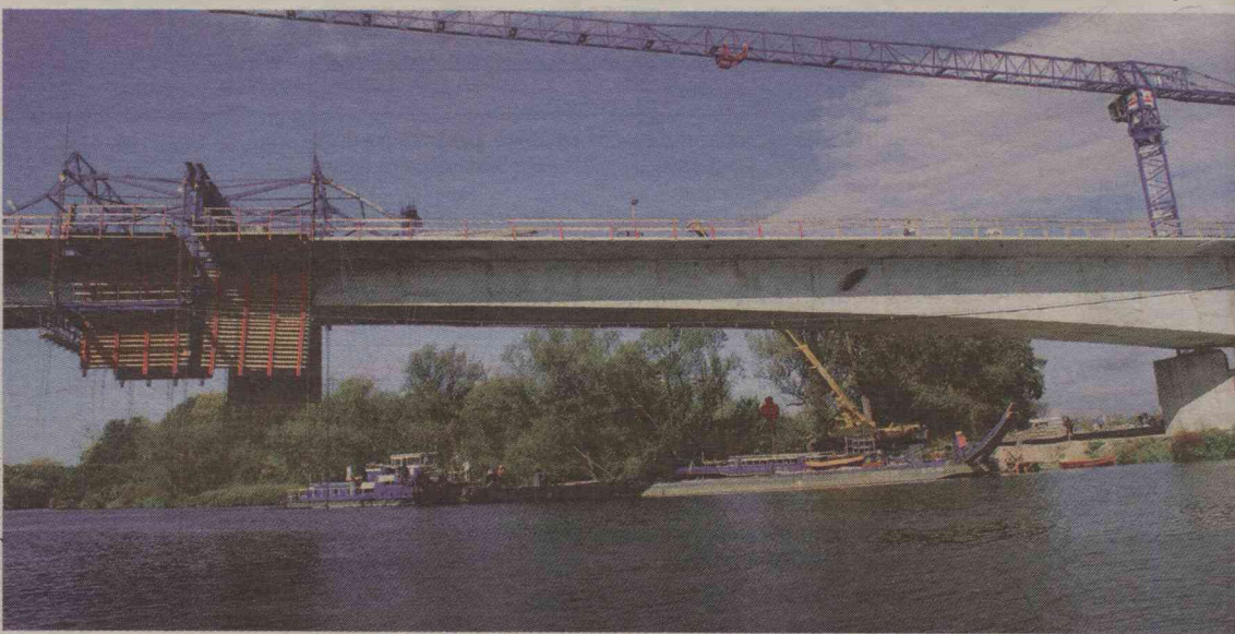
Przešlo nowego mostu nad Odrą ma długość 140 metrów. To największa tego typu konstrukcja w Polsce.
