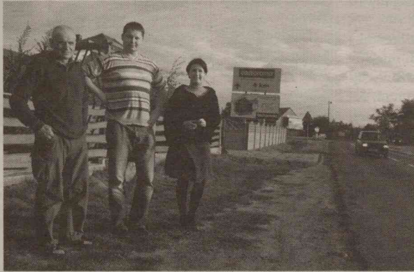
- Brak chodnika sprawia, że przy naszych domach jest bardzo niebezpiecznie – mówią mieszkańcy ulicy Kłodnickiej.
