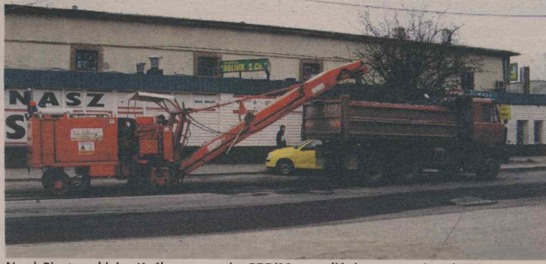
Na ul. Piastowskiej w Koźlu pracownicy PRDiM usunęli już starą nawierzchnię, a w najbliższych dniach położą nowy dywanik asfaltowy
