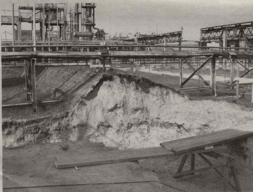
Początek prac ziemnych. W głębi widoczny stan dotychczasowy tac ochronnych.
