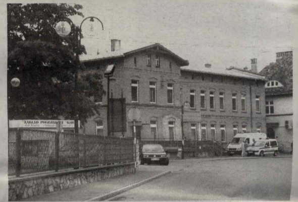
Prace remontowe w kędzierzyńskim szpitalu potrwać do listopada
