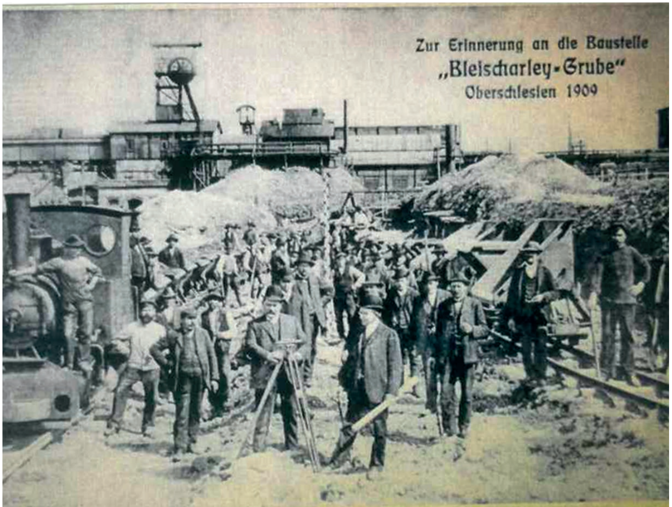
Zdjęcie przedstawia prace przy budowie kopalni „Biały Szarlej”.
