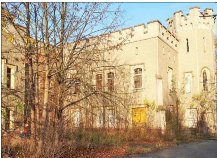
Das Gebäude ist heute in privater Hand und verfällt nach und nach zu einer Ruine.
