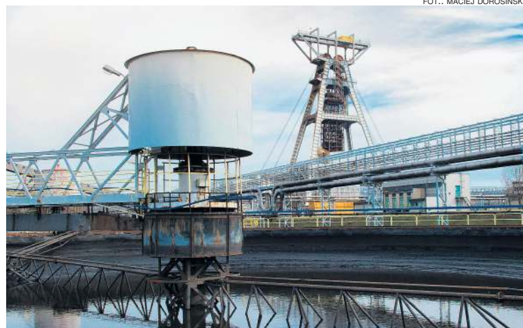
Zakład przeróbki mechanicznej węgla kopalni Budryk został oddany do użytku już po uruchomieniu wydobywania. Obecnie jest modernizowany.
