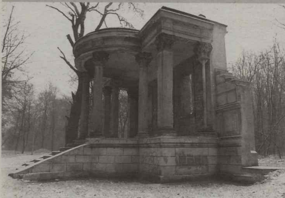
Portal bocznego wejścia XVIII-wiecznego pałacu w Ślawieście
