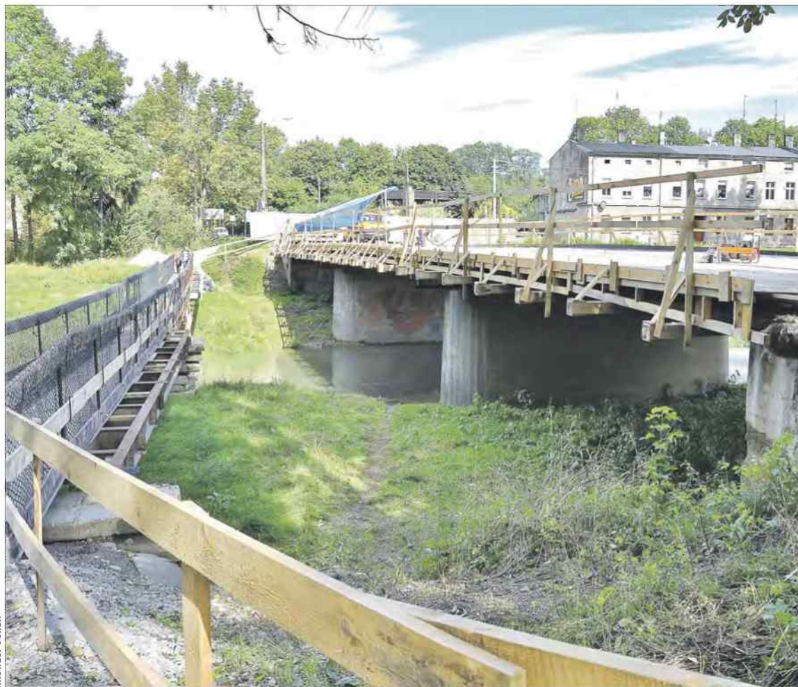
Poprzedni remont mostu na ul. Nyskiej miał miejsce w 2014 roku
