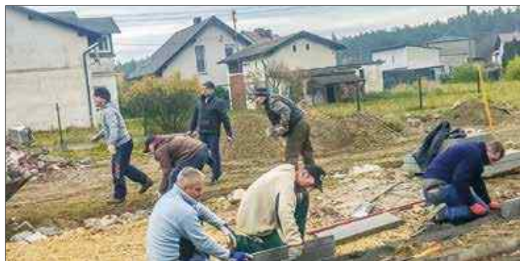
Wszystkie ręce na pokład - mieszkańcy Kielczy postanowili włączyć się w budowę parkingu
