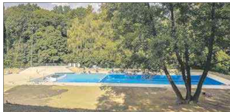
Na leśnickim basenie trwają prace wykończeniowe
