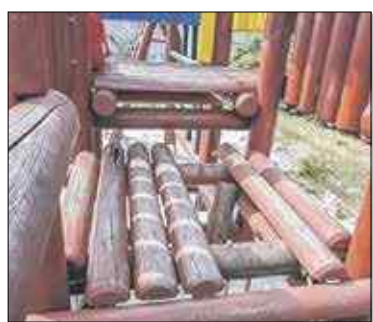
Prace remontowe mają zostać wykonane do 31 lipca
