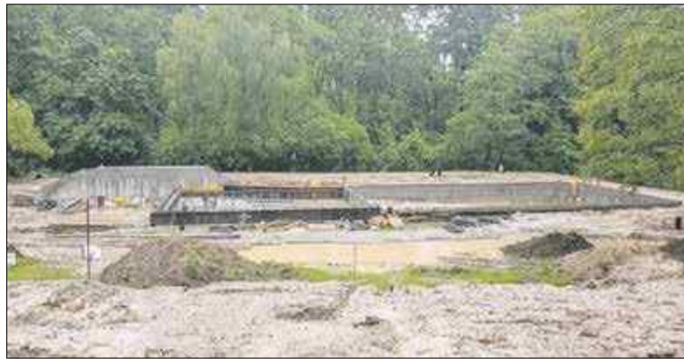
Jeszcze trochę pracy i basen będzie gotowy
