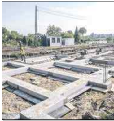
Fundamenty nowych domków
