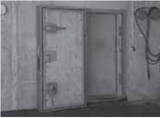
Wejście do jednego ze schronów w domu mieszkalnym w Szwajcarii. Fot. T. Wiczorek.
