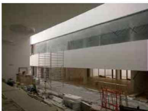
Nowa biblioteka w budowie. Fot. Radio Opole. telskiego przeznaczyć na wyposażenie biblioteki. Po 70 latach jej funkcjonowania nareszcie będzie miała piękną i nowoczesną siedzibę. – wyjaśnił w rozmowie z reporterem „Radia Opole” Jan
