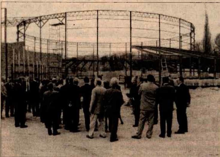
Radni Powiatu Nyskiego wizytują budowę oczyszczalni ścieków w Paczkowie
