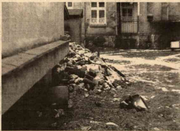
Pozostałości po remoncie wymiennikowni.
