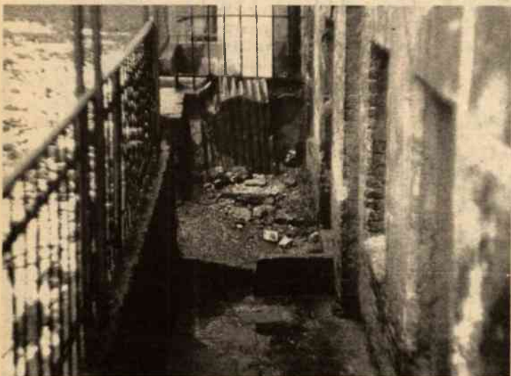
Halda śmieci tuż pod oknami mieszkań
