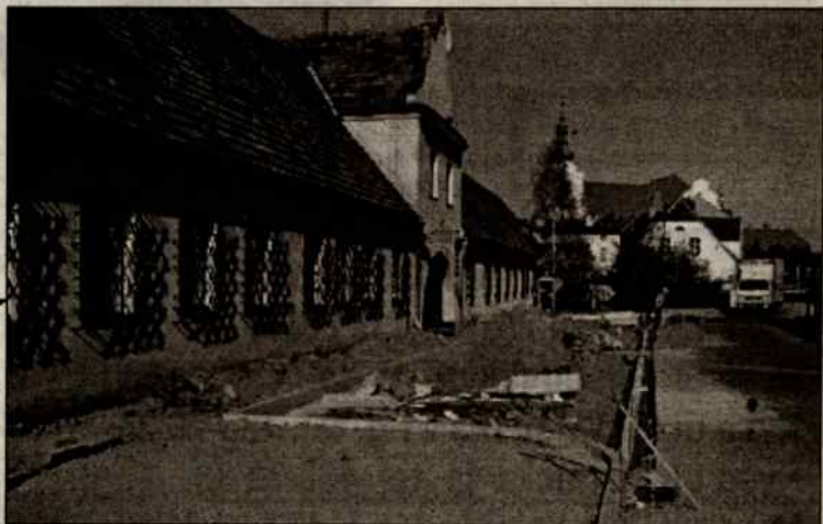
Remontowana ulica Wyzwolenia
