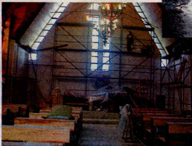
Remont kaplicy trwa
