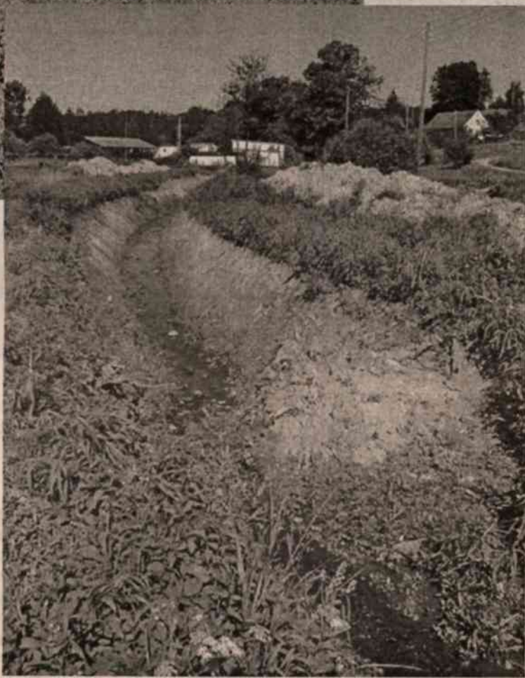
...i zatarasowany rów odprowadzający wodę
