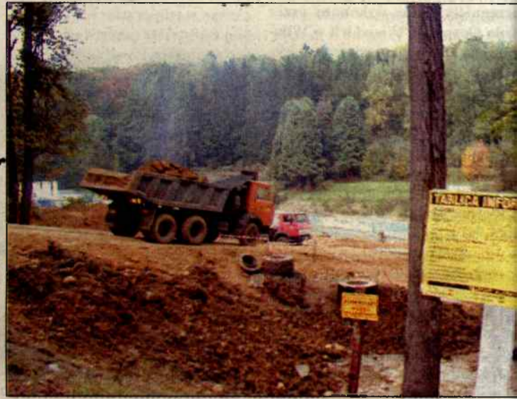
Praca na budowie wre
