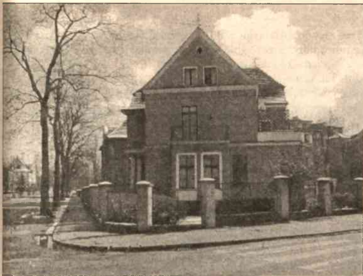
Budynek byłej przychodni przy ul. Wojska Polskiego
