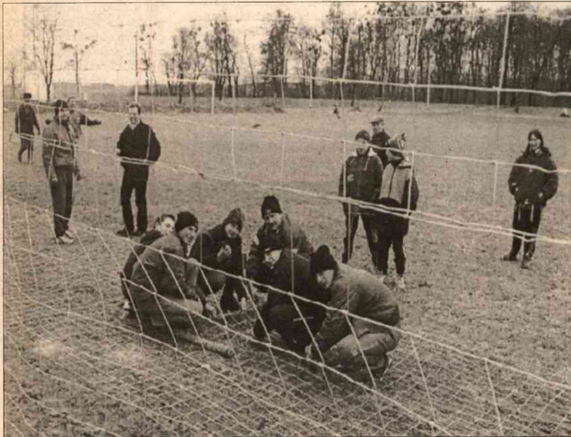
Członkowie LZS przy montażu siatki ogrodzeniowej
