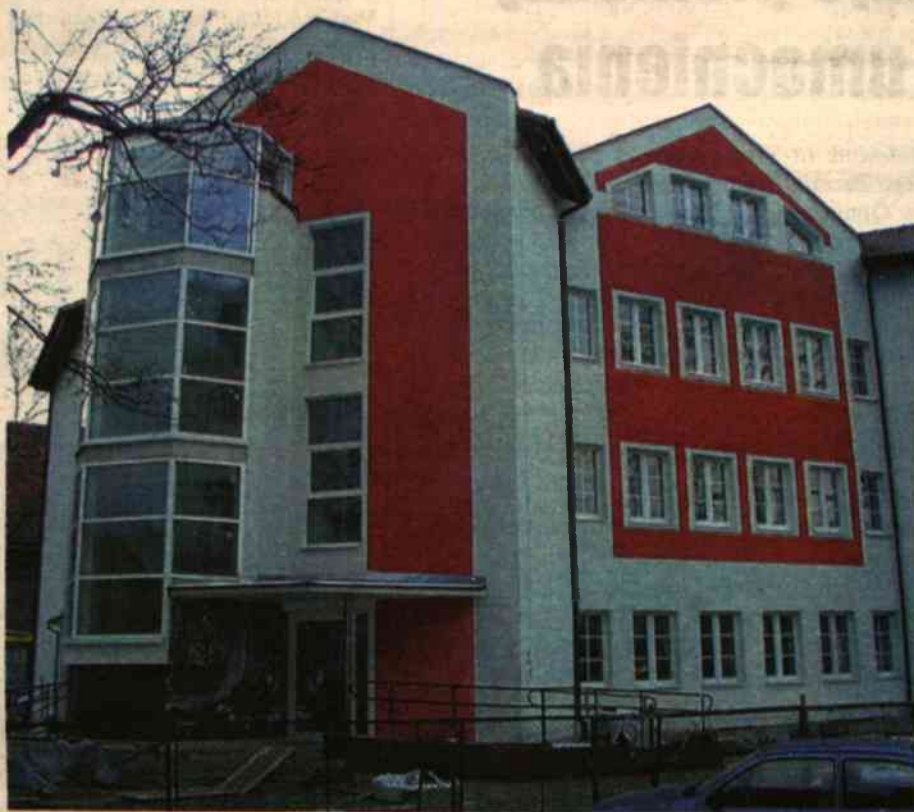
Na zdjęciu: Budynek nowej przychodni
