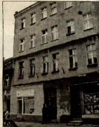
Z okna tej kamienicy wypadło dziecko
