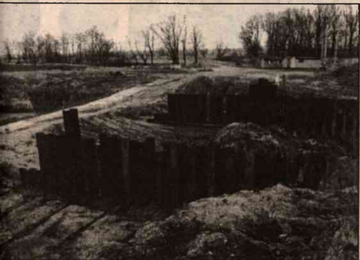
Obecny stan niedokończonej elektrowni
