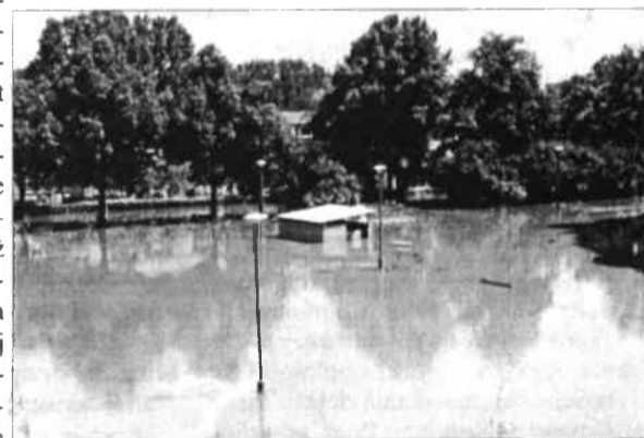
Woda w Opolu w dalszym ciągu czyni spustoszenia
