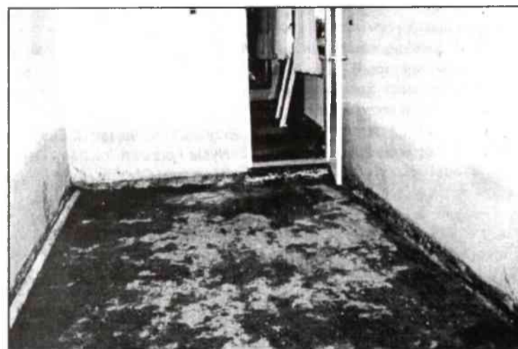
Konradowa - tą podłogę trzeba było zerwać
