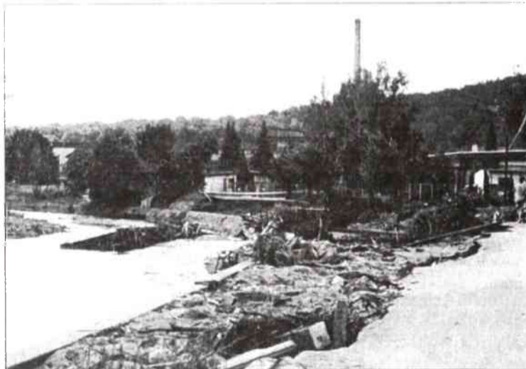
Ulica Andersa i nie istniejący już dziś most kolejowy
