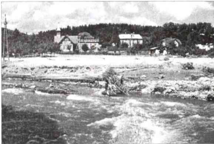
Zniszczenia wzdłuż Białej Głucholaskiej
