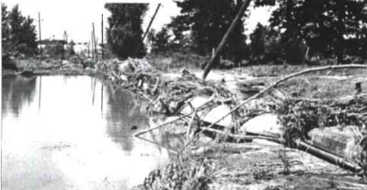
To co widać, to pozostałość po taśmociągu
