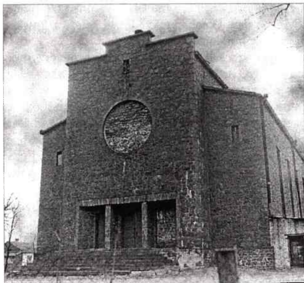
44. Kościół parafialny pw. Przemienienia Pańskiego w Sarnach z zewnątrz przed rozpoczęciem remontu (1992). Ze zbiorów ks. Witolda J. Kowalowa.
