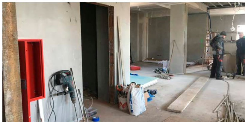
W budynku dawnego kościoła trwa generalny remont
