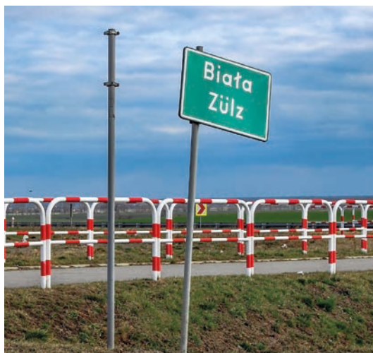
Oderwana tablica wjazdowa do miejscowości
