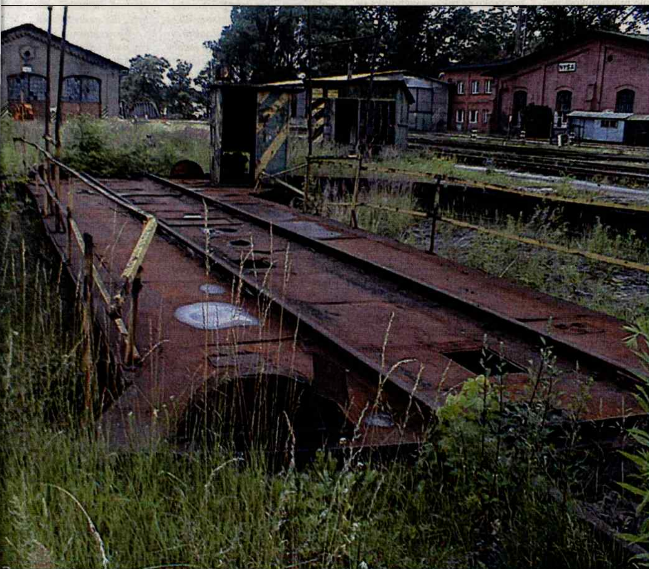
Na stacji Nysa niszczej budynki i urządzenia
