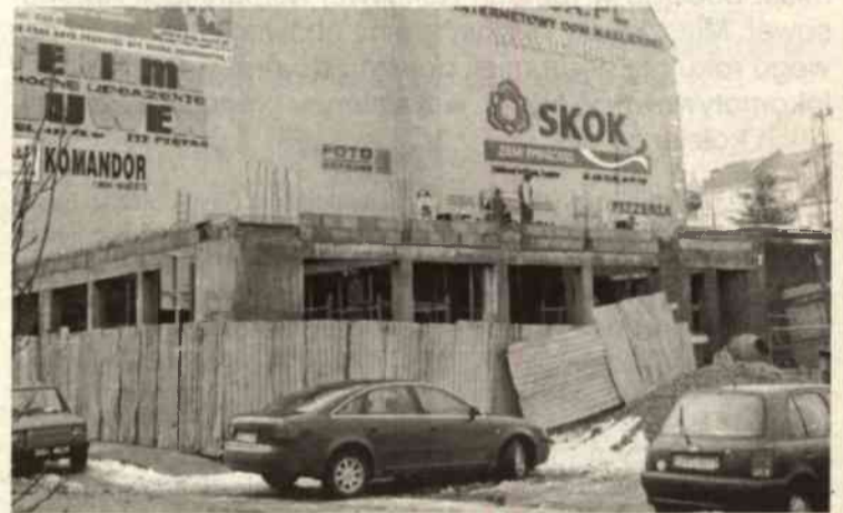
Ruszyła budowa nyskiego ratusza
