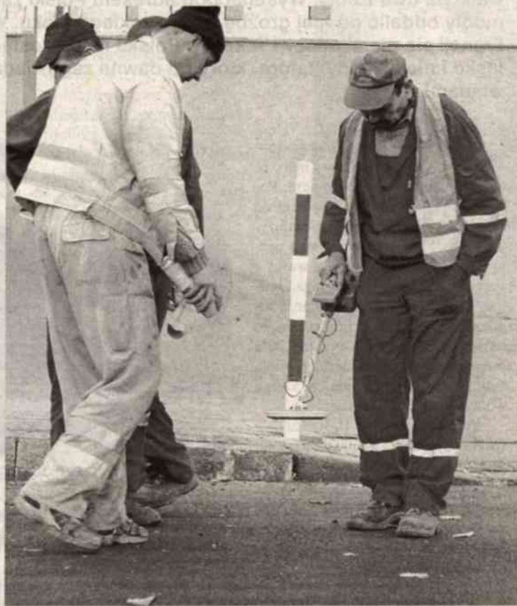
Pracownicy szukają zalanych asfaltem zaworów
