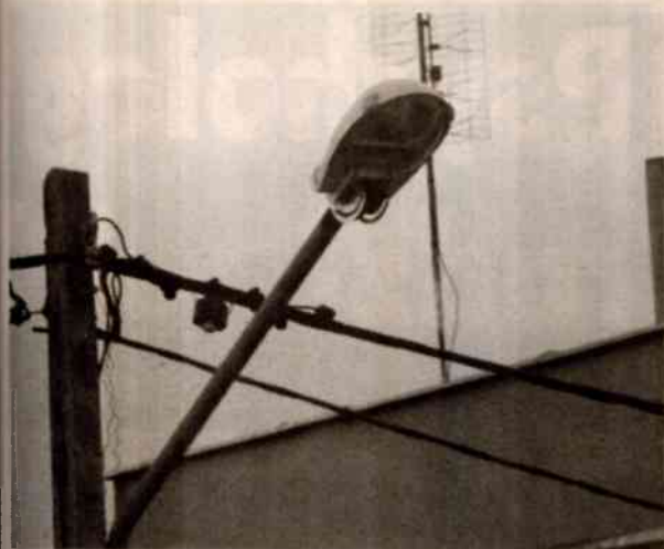
Zostanie wymienionych ok. 70% żarówek w lampach ulicznych, w całej gminie
