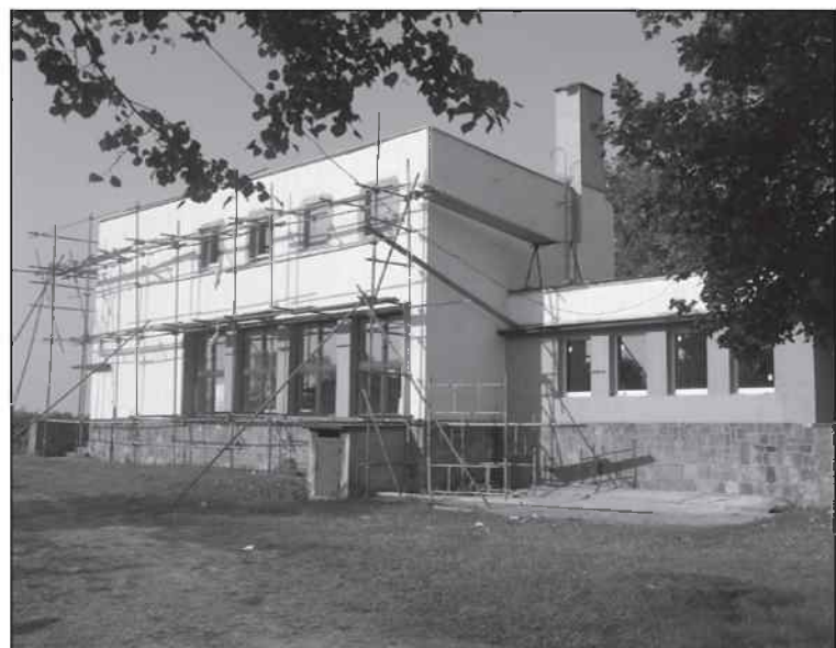
Szkoła w Zimnej Wódce podczas remontu
