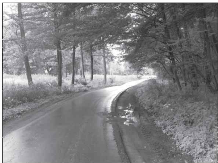
Droga w Czarnocinie, mogłaby się nadawać na przyjęcie większego ruchu samochodów, gdyby miała grubszą nawierzchnię i przynajmniej metr więcej szerokości
