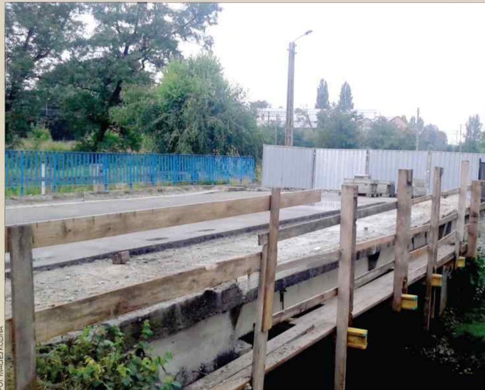
Zakres robót obejmie również oczyszczenie dna rzeki pod mostem
