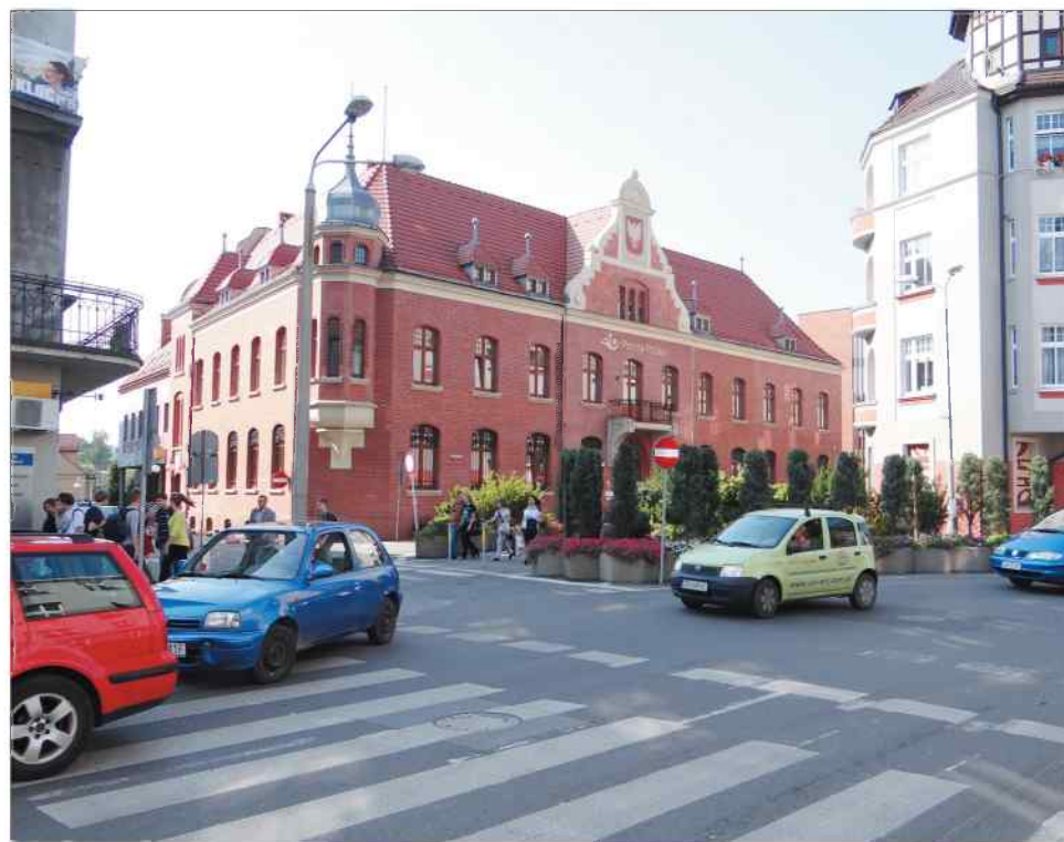
A tak wygląda dziś budynek rybnickiej poczty
